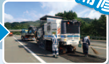
切削機という機械で アスファルトを削る
